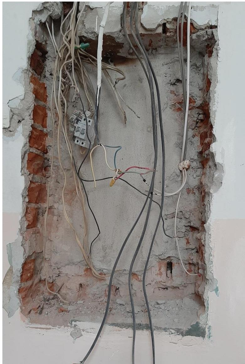
**Общий вид работ после демонтажа/монтажа щитов этажных, счетчиков собственников, автоматов собственников, стальных труб, штукатурки и шпатлевки штроб в МКД Державина-5
